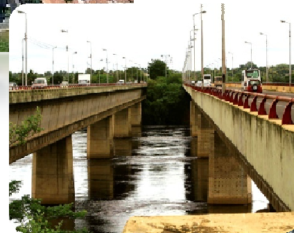
Puente Dalla Costa
